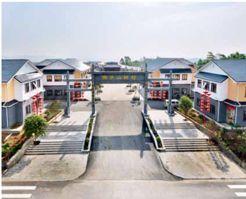
四川广安新农村建设项目
